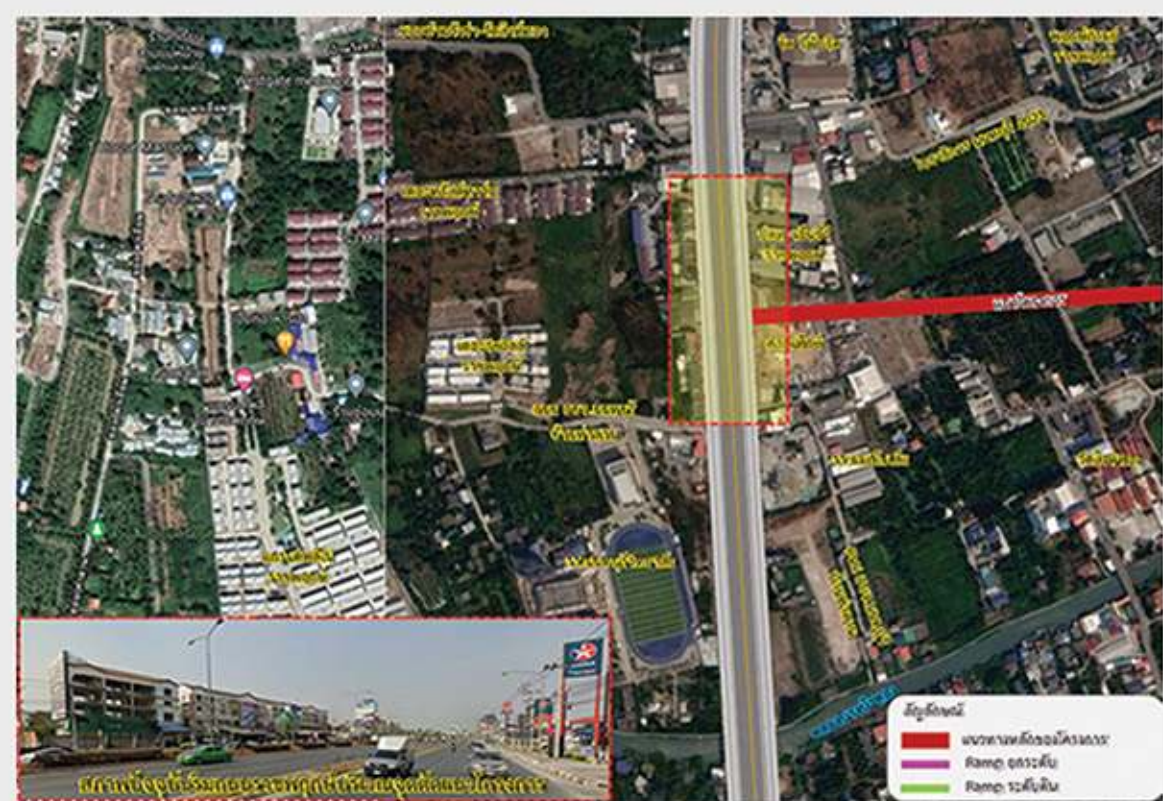
สภาพพื้นที่ปัจจุบันบริเวณทางแยกต่างระดับบริเวณจุดตัดถนนราชพฤกษ์
